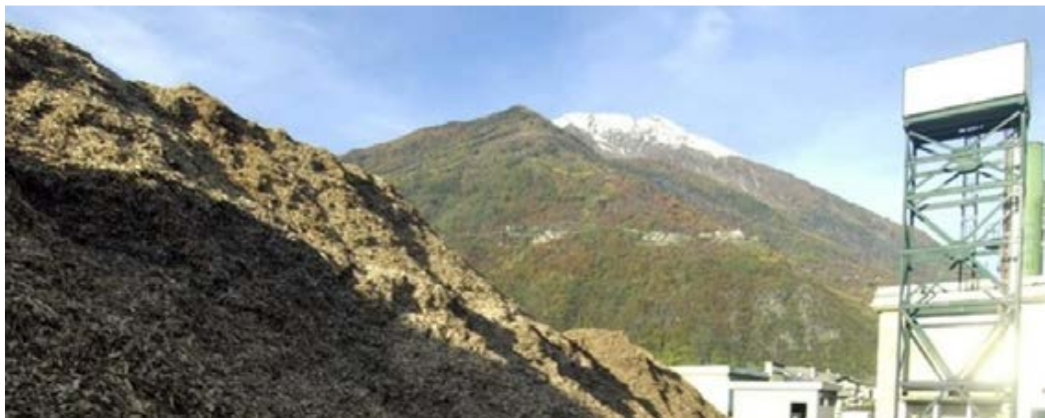
La centrale di Tirano
