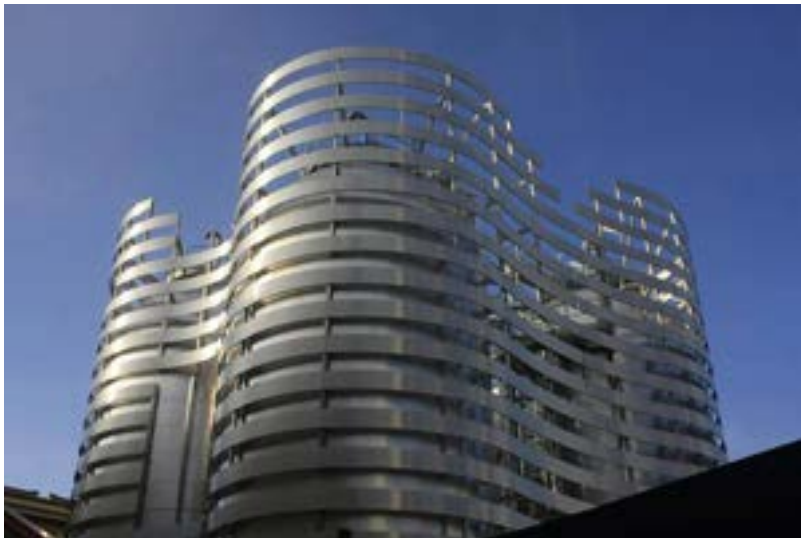
Impianto di teleriscaldamento
