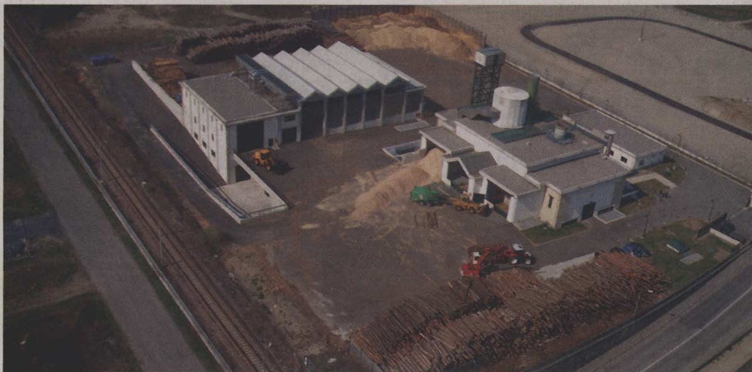
■ La centrale per la cogenerazione e il teleriscaldamento in Valtellina.
