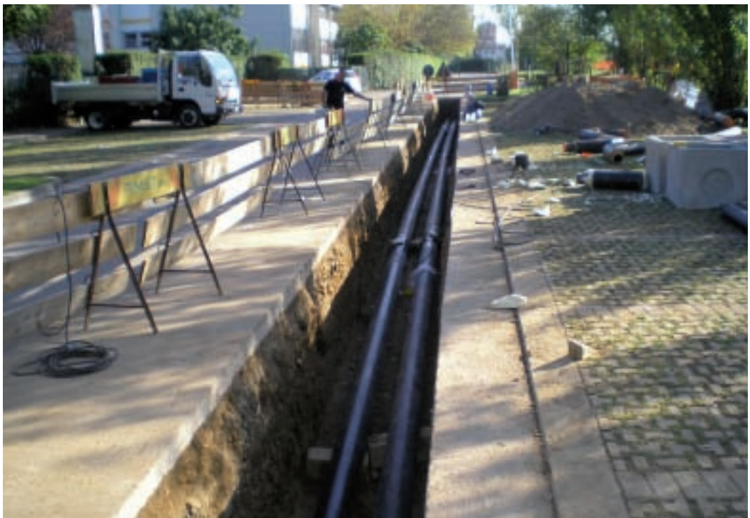
Figura 9 - Posa delle tubazioni della Rete di Teleriscaldamento a servizio di una centrale di cogenerazione.
