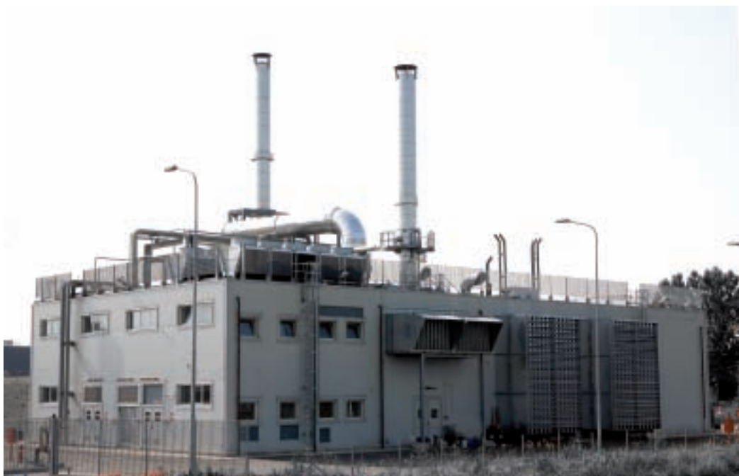
Figura 8 - Impianto di cogenerazione abbinato al teleriscaldamento
